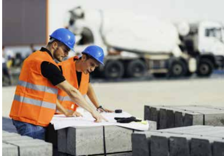
Der Altersdurchschnitt der Branche liegt bei 39,4 Jahren
